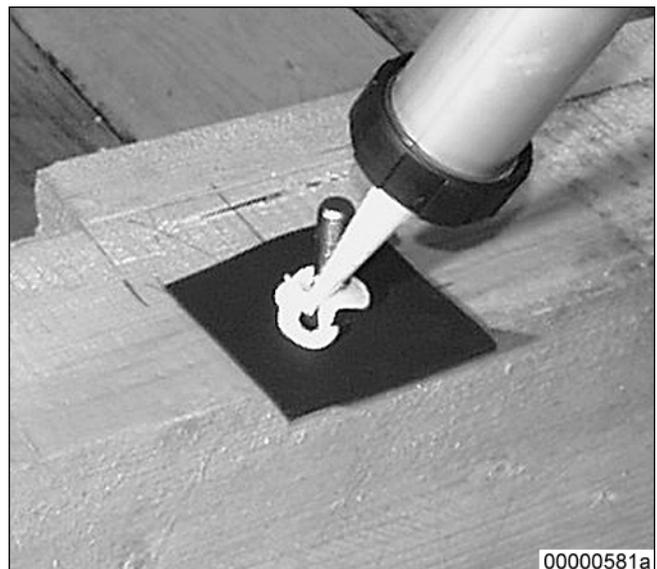
Nach dem Einlegen der Aluminiumverbundfolie in der Schraubendurchführung, diese satt mit dauerelastischem Dichtungsmaterial (Loctite 5970, MTU Sachnr. 50773) einstreichen.
