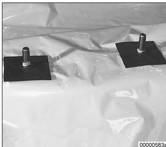
Über die obere Hartgummischeibe, zum zusätzlichen Schutz der Aluminiumverbundfolie Schaumfolie legen. Das Gesamtsystem wird nach Aufbringen und Festschrauben der Motorlagerung fest verpresst und dicht.
